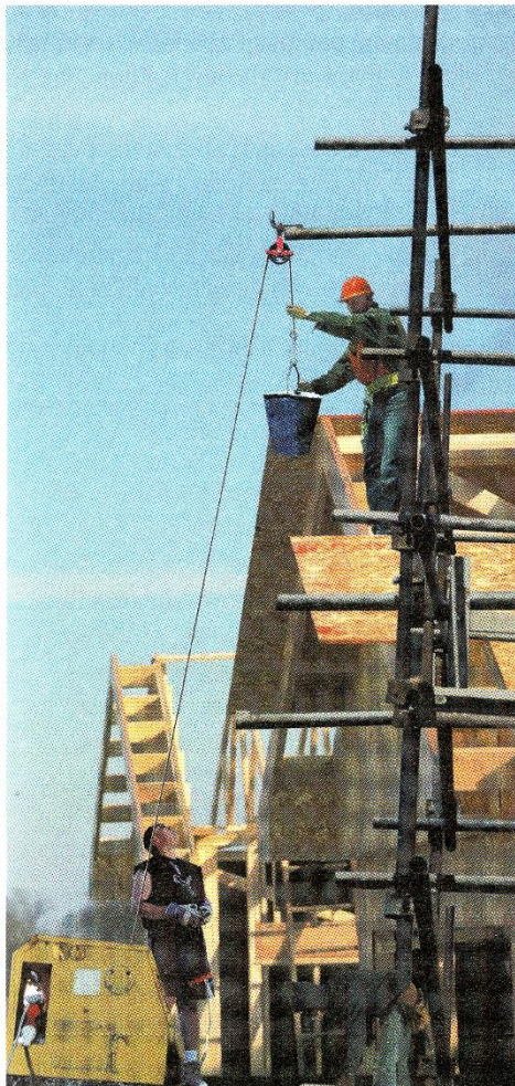
Obr. 1.95 Užití pevné kladky
